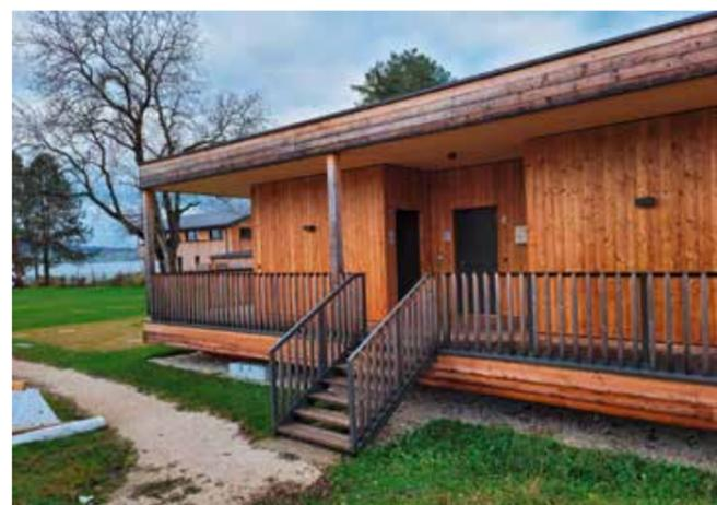
Das Gebäude wurde gegen Hochwasser durch eine bauliche Maßnahme geschützt, indem das Gebäude unterströmt werden kann
